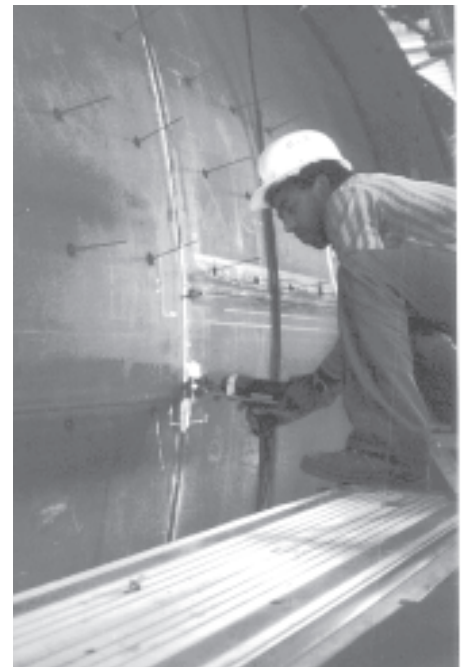
ISOLATION EINER BRENN-KAMMER
